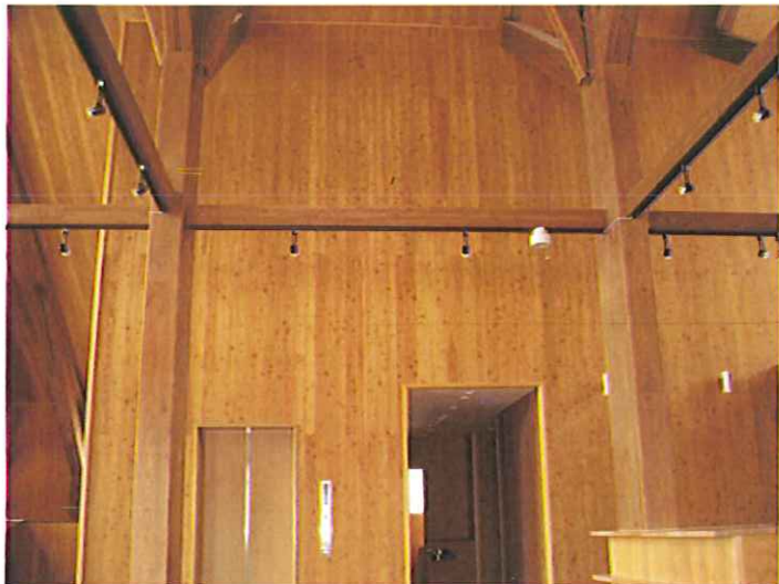
札幌市滝野公園内・ホール・唐松羽目板・札幌開発建設部
